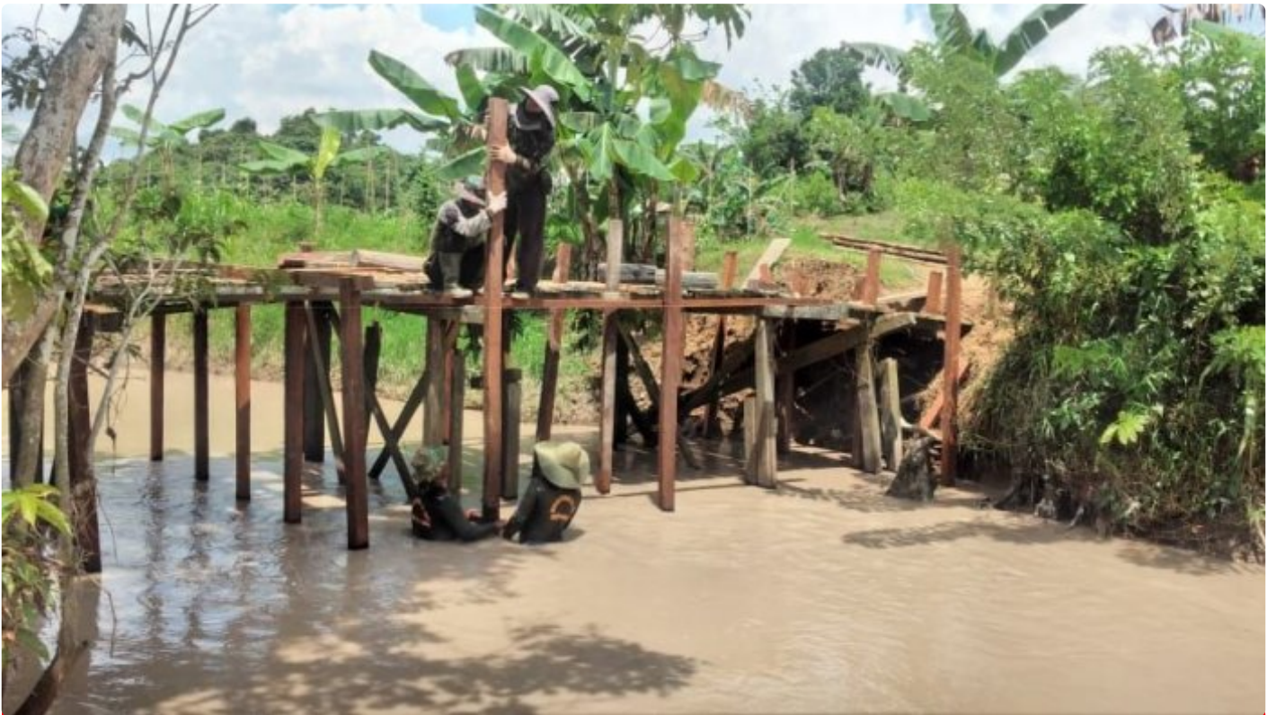
Karya Bakti Kodim 0906/Kkr sasar pembangunan jembatan penghubung kawasan pertanian desa Buana Jaya
